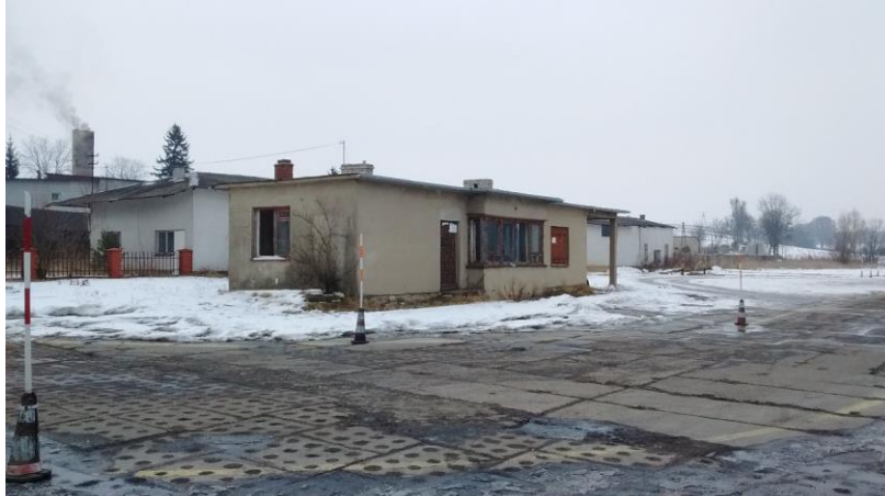
Fotografia 2 Dawny budynek wagi na obszarze przemysłowym i kolejowym w Iwaniskach
